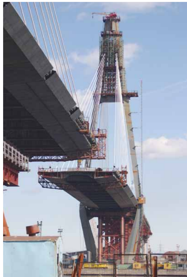
Монтаж пролетного строения вантового моста через Неву
