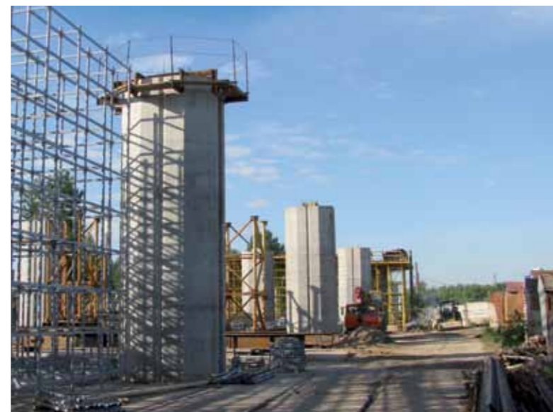
Строительство продолжения Пискаревского проспекта на участке от ул.Руставели до КАД
