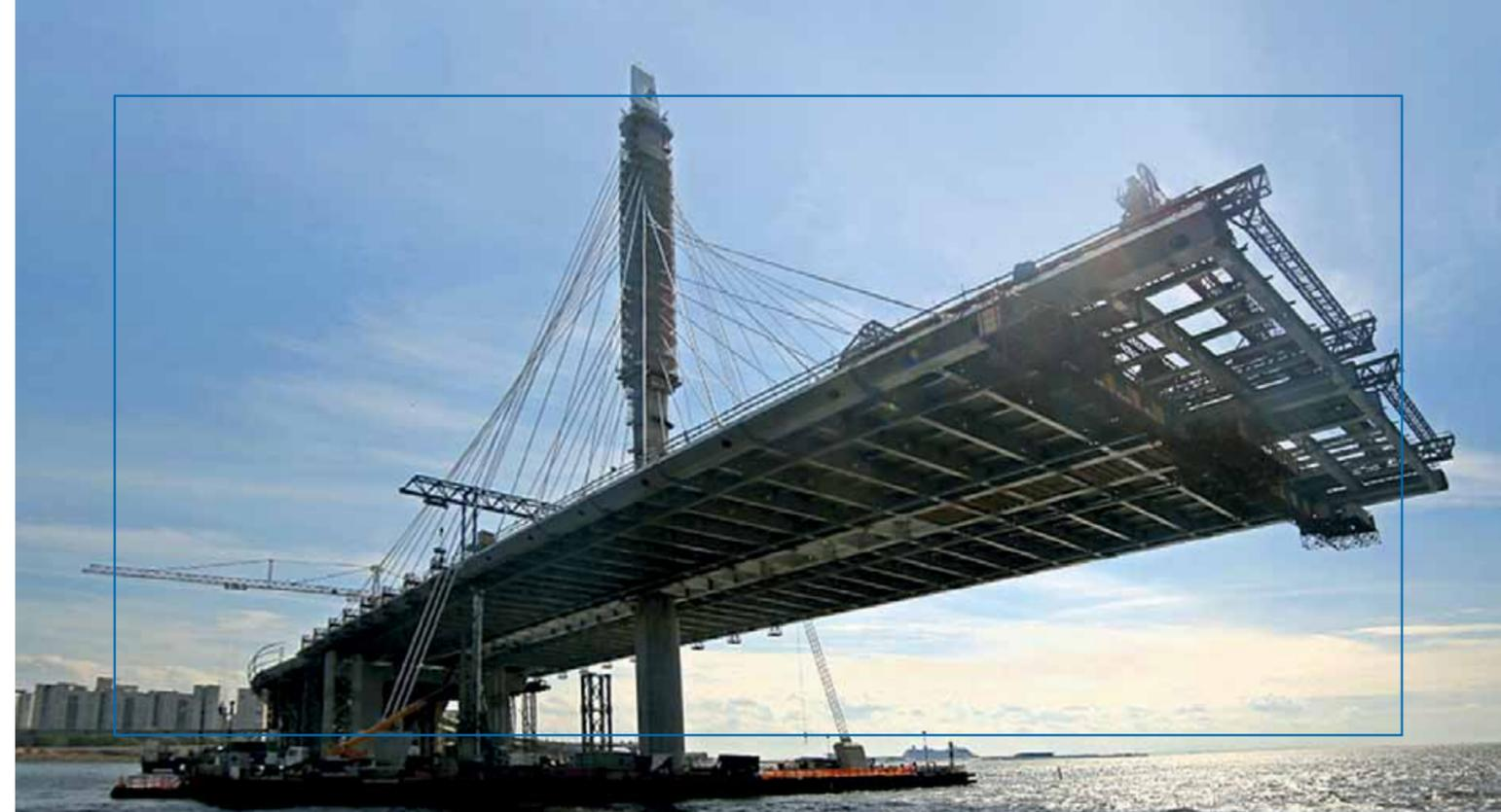
Оптимальным решением для моста через Петровский канал стала следующая технология: укрупнительная сборка на стапеле и продольная надвижка – для боковых пролетов; встречный навесной монтаж с использованием монтажных агрегатов и плавсистемы – для центрального вантового пролета.
