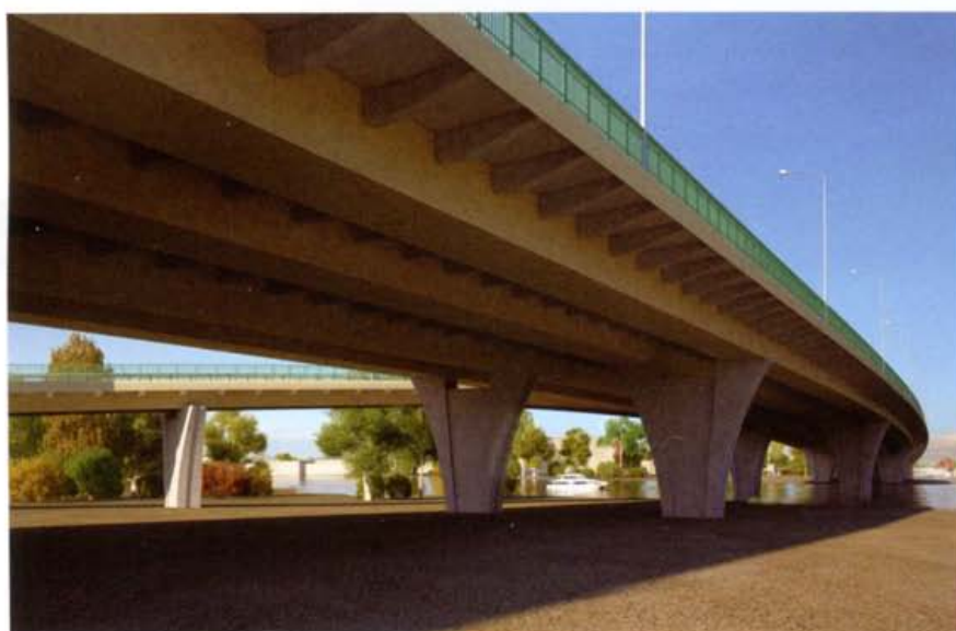
Строительство эстакады «Восточная»
