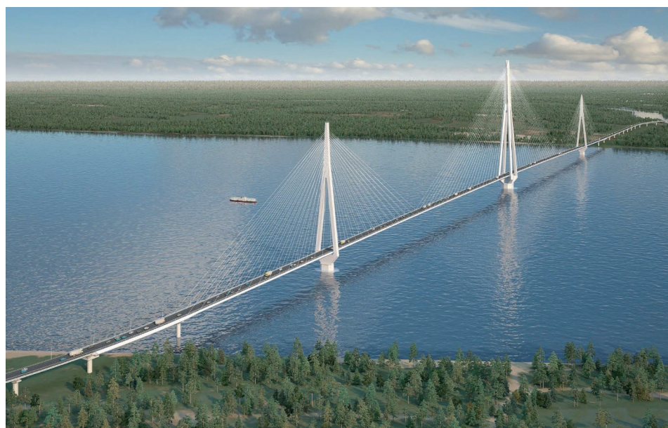
Мостовой переход через Лену в районе Якутска
