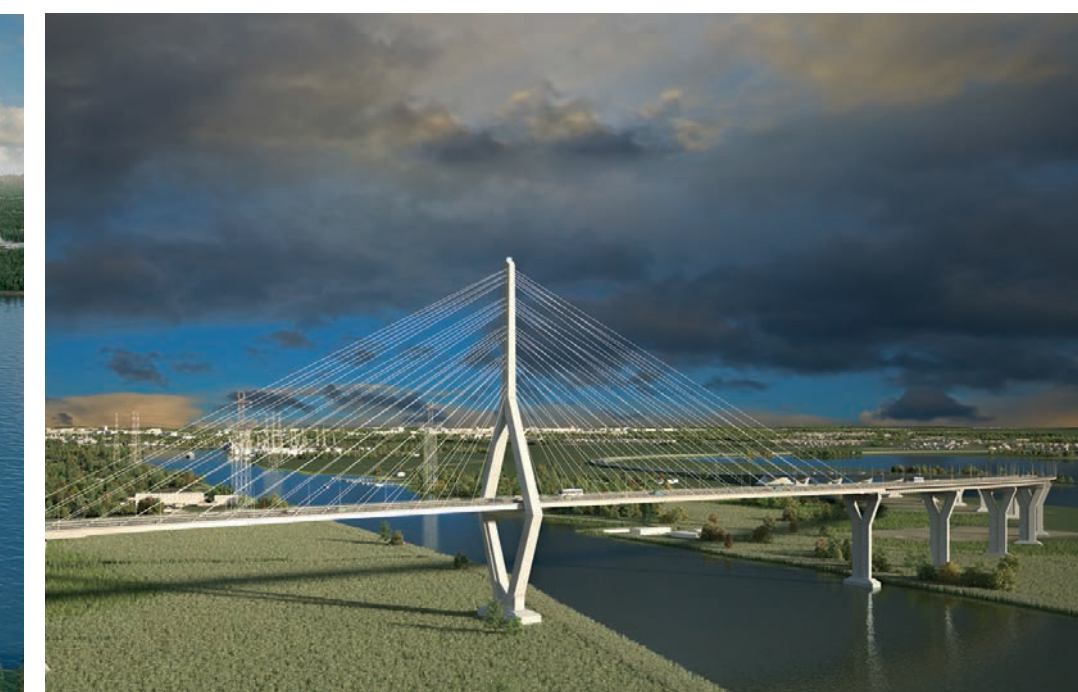
Мостовой переход через Калининградский залив
