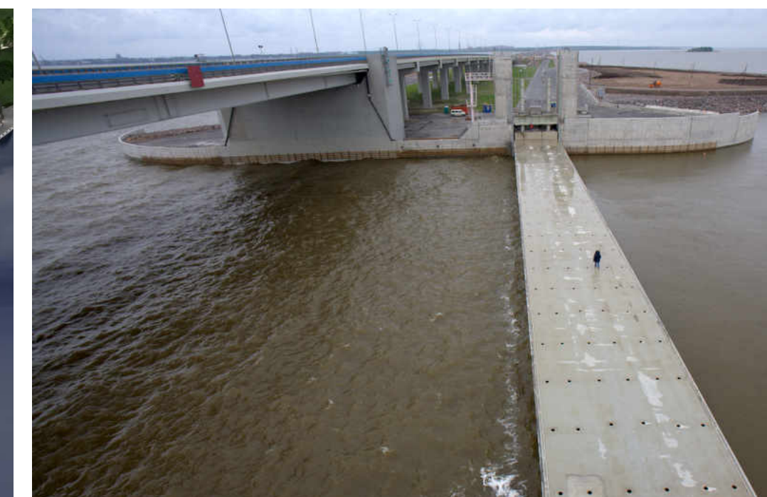
Судопропускное сооружение С-2, Санкт-Петербург
