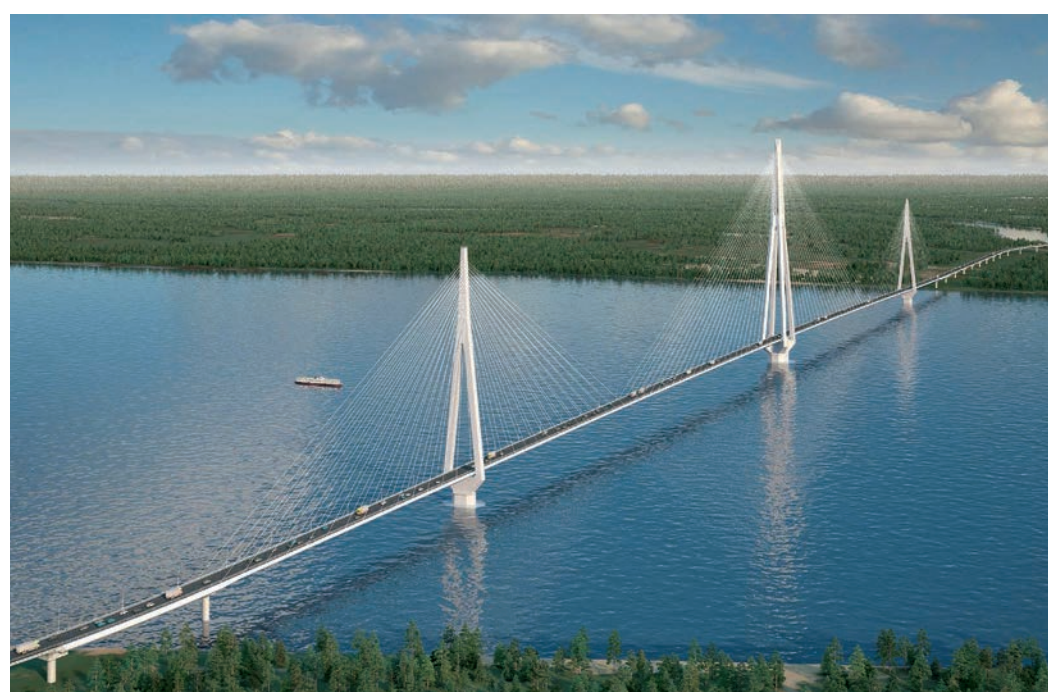
Мостовой переход через Калининградский залив
