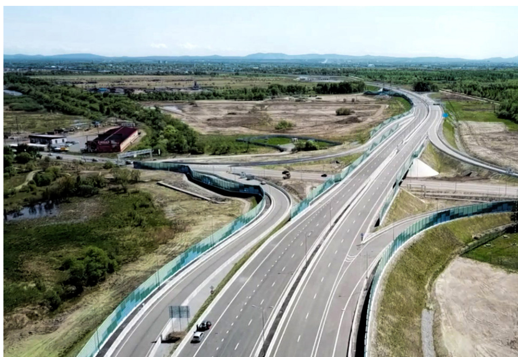
Обход Хабаровска км 13 - км 42
