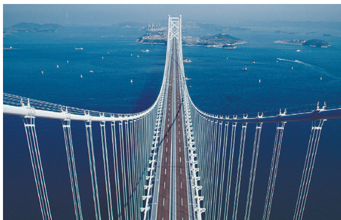
Рис. 2. Кабели висячих мостов с применением PPWS
