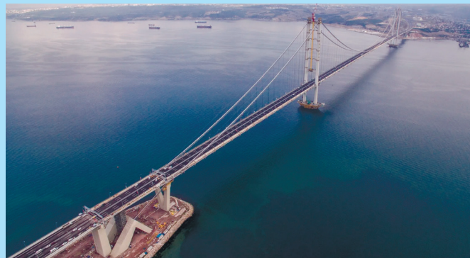
Рис.10. Мост Османгази (Osman Gazi Köprüsü)
